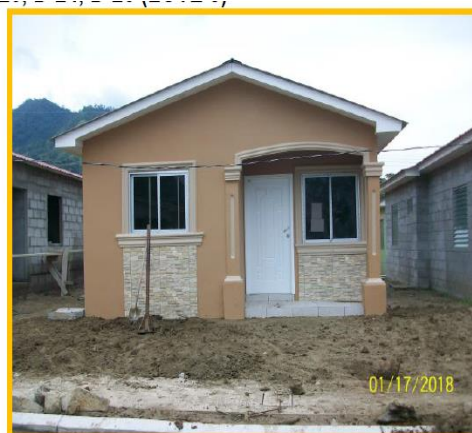
VIVIENDA E-8 (LOTE 8)
